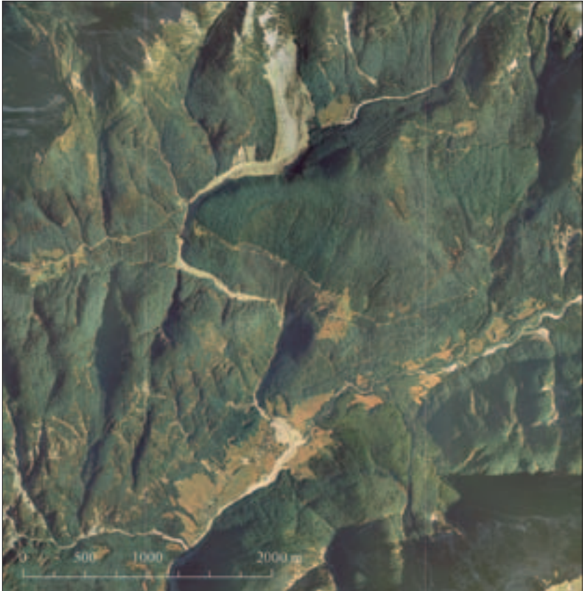
Slika 12: Plaz Stovžje (zgoraj), pot (na sredini) in vršaj drobirskega toka v Logu pod Mangartom (spodaj) (barvni ortofotografski posnetek, © Geodetska uprava Republike Slovenije 2005).
