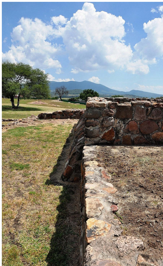
Figura 4.9. Huandacareo, Montículo 2, vista hacia el oriente a lo largo del paño norte del edificio superior.
