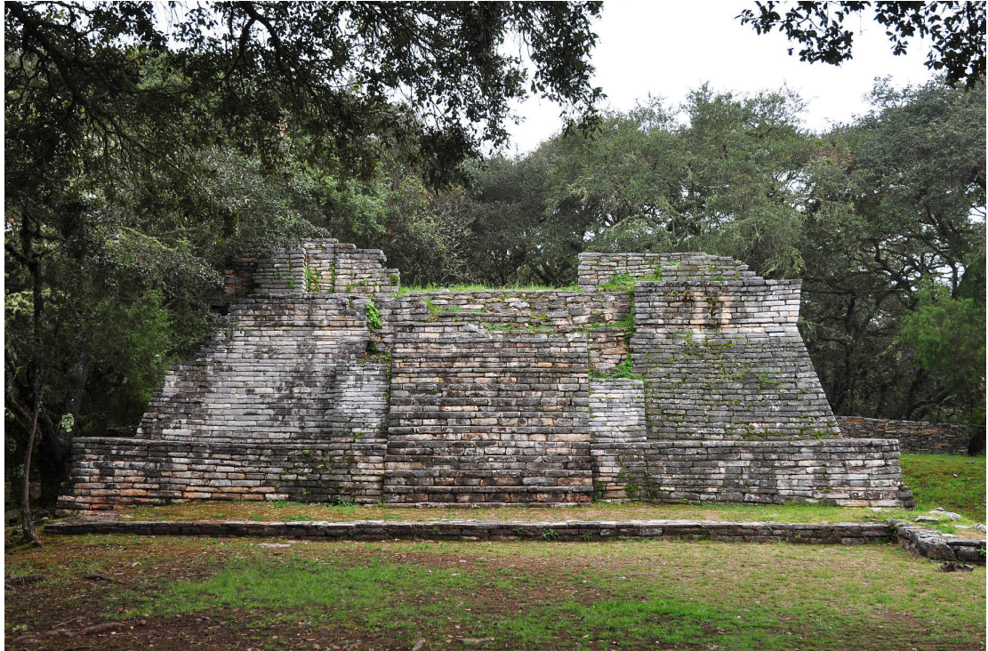
Figura 4.16. Toluquilla, Estructura 57, vista hacia el sur.
