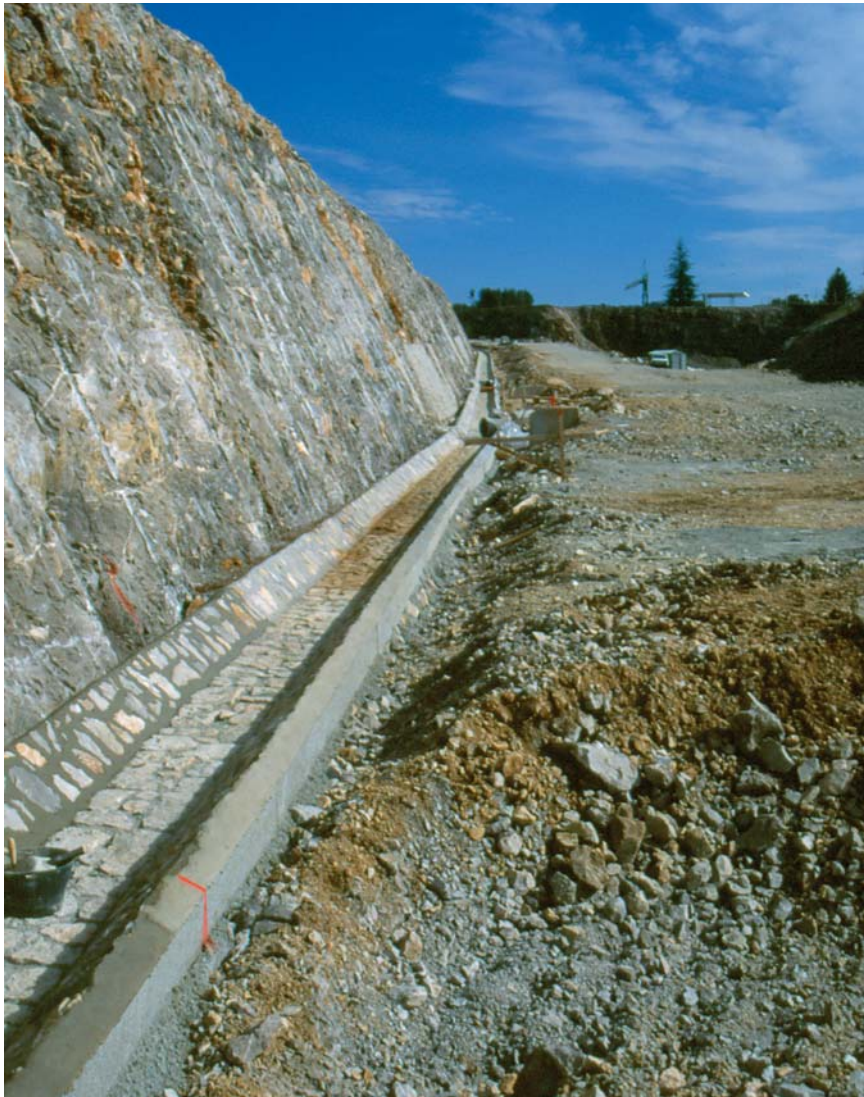
16 Žlebovi za odvodnjavanje na robu cestišča. Gutters for drainage water at the edge of the roadway.
