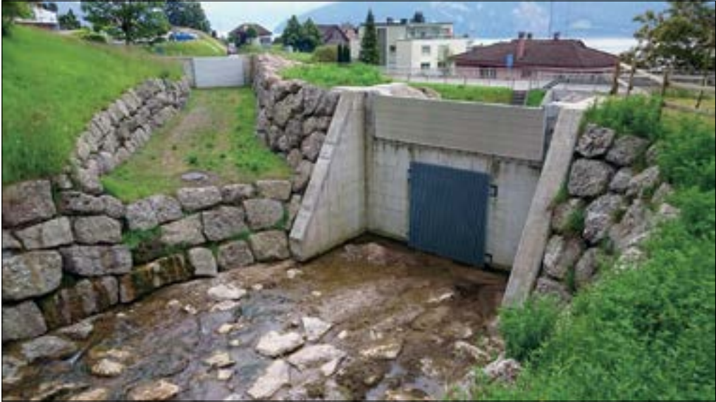
Slika 1: Vtok z rešetko v obzidano kineto in levi bočni preliv za visoke vode kot gradbeni protipoplavni ukrep na hudourniku v kraju Weggis v kantonu Luzern (Švica).
