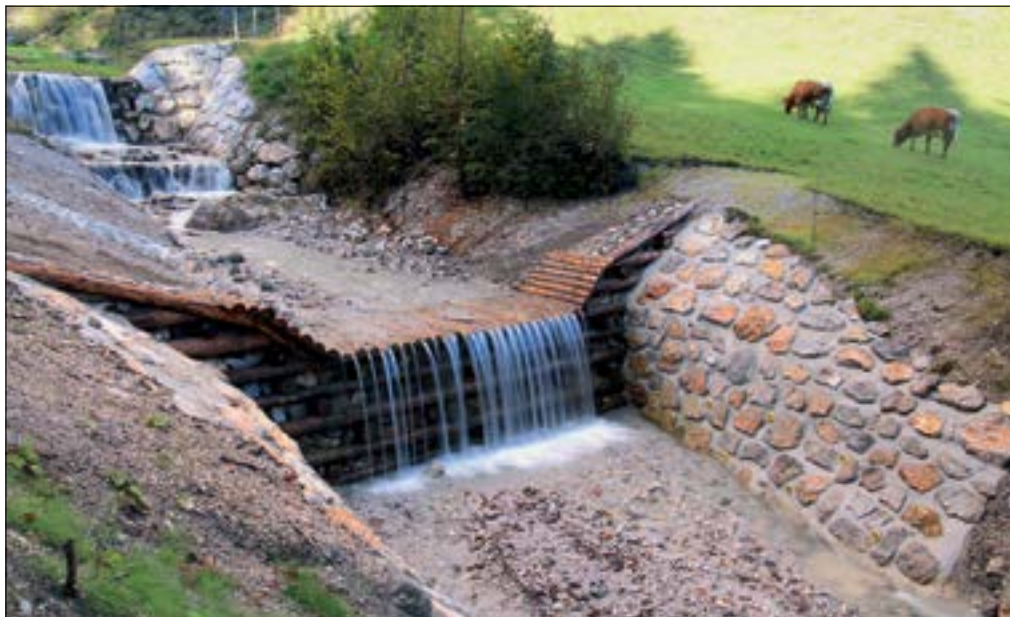
Slika 1: Prečni ustalitveni objekt – dvostenska lesena kašta (kranjska stena) na Blatnici v Klemenčevem, zgrajena poleti leta 2015. Lesena kašta je tehnika, ki se uporablja pri urejanju vodotokov ter tudi širše pri sanaciji erozijskih žarišč in zavarovanju nestabilnih pobočij.
