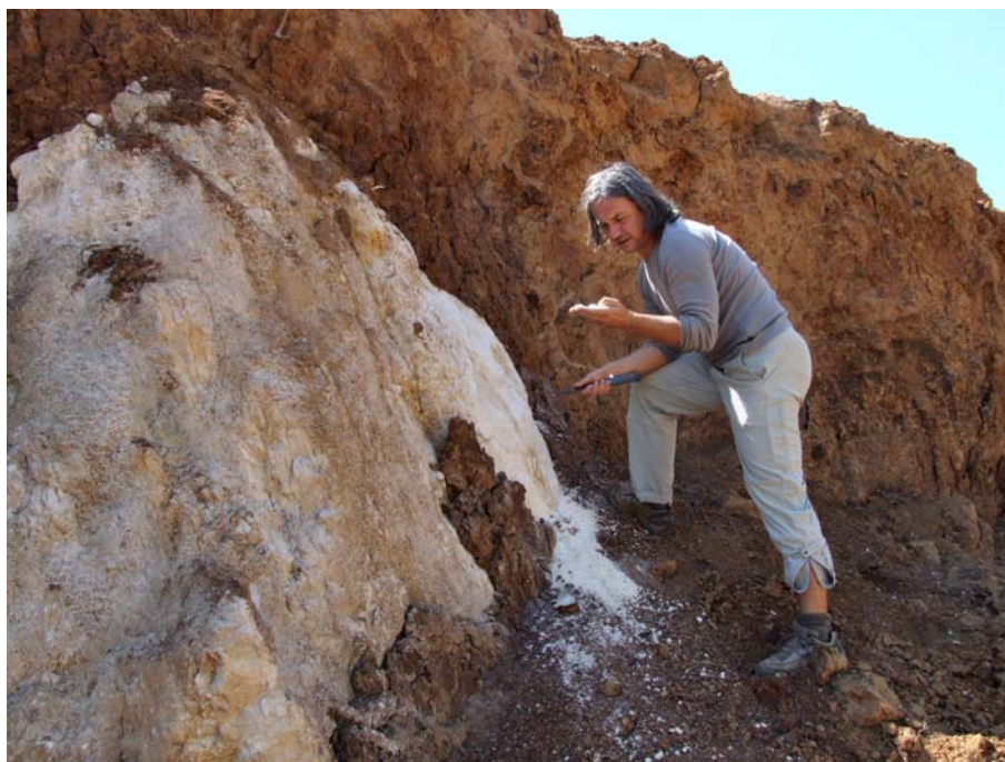
Slika 1.1.1. Do mehkega preperel apnenec pod debelimi sedimenti; gradbišče avtoceste severovzhodno od Novega mesta.
