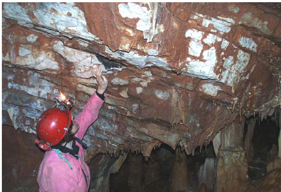
Slika 5.5.7. Na severni steni v začetnem delu Stranskega rova je mesto odvzema vzorca Kr1 .
