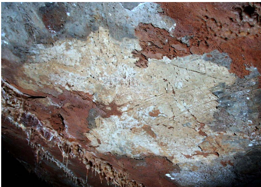
Slika 5.5.6. Preperela kamnina je mestoma spet cementirana, siva področja.
