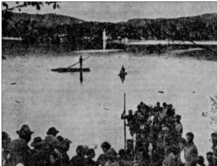
Slika 12: Ob poplavah v Strugah septembra 1933 je po pisanju takratnih medijev ( Na pomoč... 1933, 3; Vesoljni ... 1933, 1 ) do strehe 12 m visoke cerkve manjkalo le nekaj centimetrov, do nje pa je bilo mogoče priti le s čolni ( Struge na ... 1933, 3 ).
