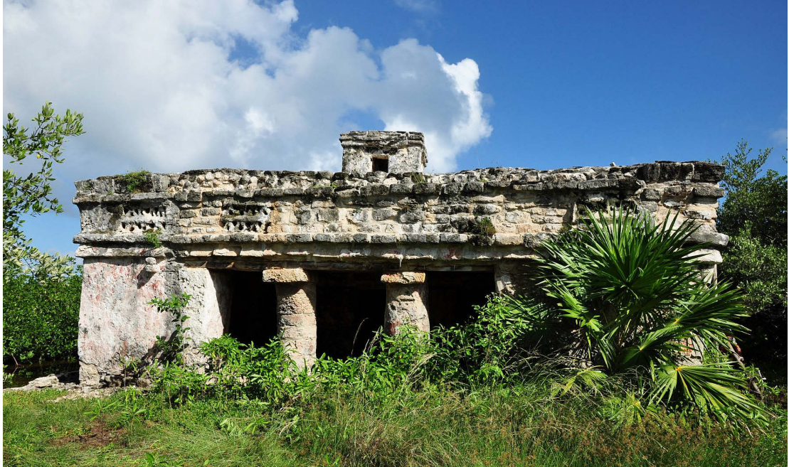
Figura 3.13. Tupak, templo, vista hacia el oriente.
