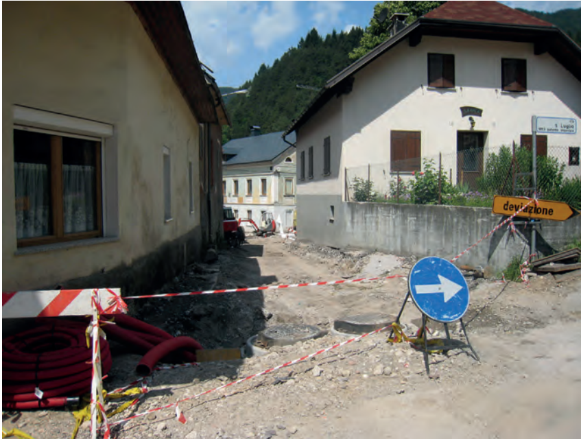
Slika 5: Obnovitvena dela v vasi, 4. 7. 2008.
