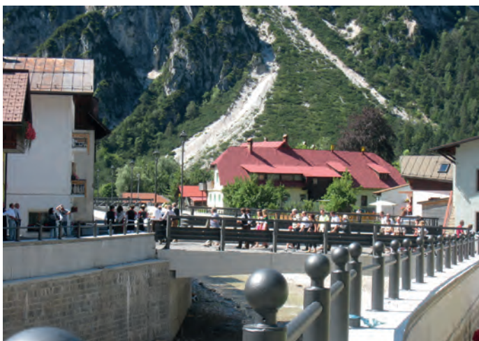
Slika 63: Sprevod prečka obnovljeni most čez potok, 26. 7. 2009.
