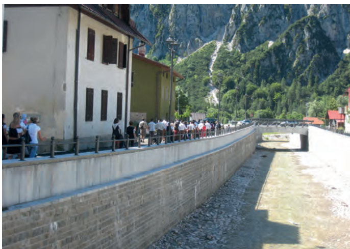
Slika 64: Sprevod ob levem bregu obnovljene struge potoka, 26. 7. 2009.
