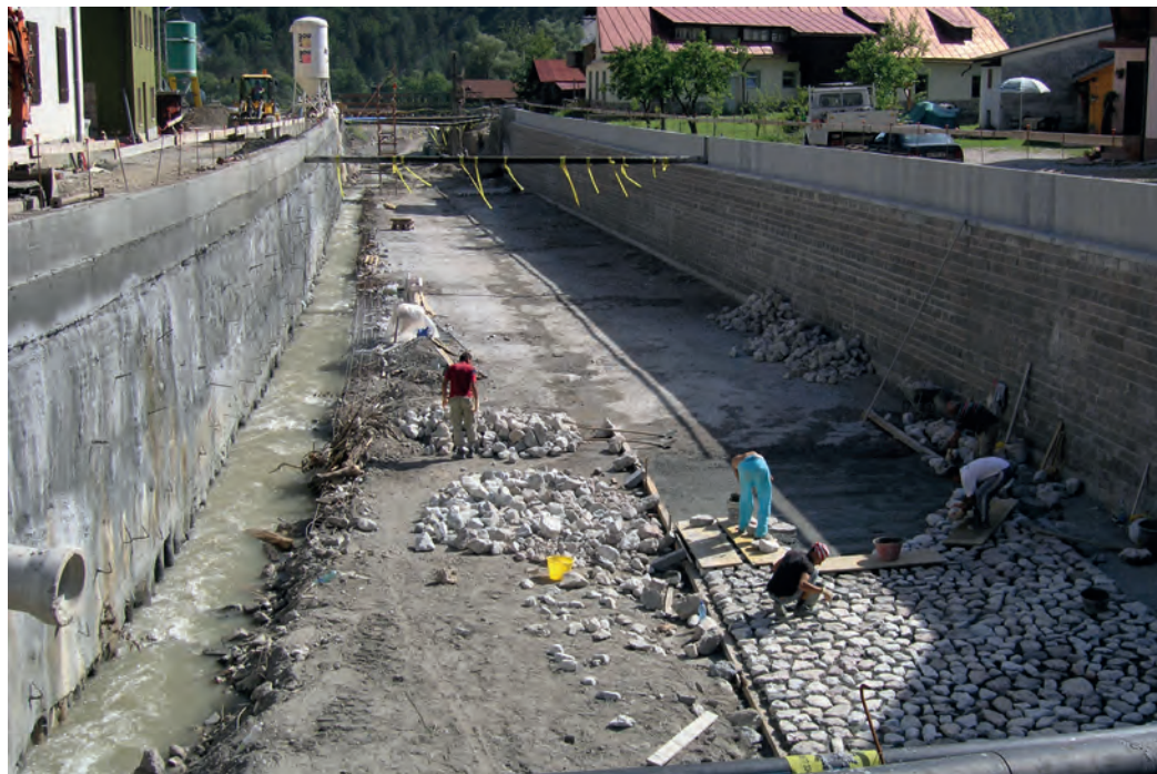
Slika 3: Obnovitvena dela v strugi potoka, 18. 7. 2007.
