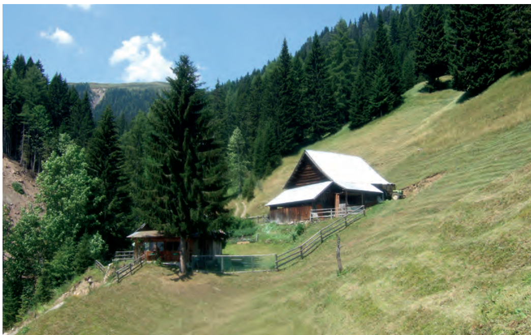
Slika 2: Bajta družine iz Ukev na planini, ogrožena zaradi zemeljskega usada, preden so jo izpraznili in se vselili v nadomestno na varnejšem kraju, 22. 7. 2006.
