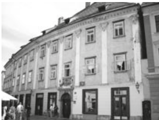
Palača grofov Ursini-Blagay na Starem trgu 21 v Ljubljani, prezidana sredi 18. stoletja (foto: Dušan Kos).
