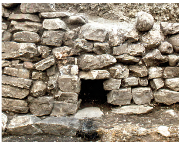
Sl. 12: Hiša 8/1. Niša v drenažnem zidu. Fig. 12: House 8/1. Hole in the drainage wall.
