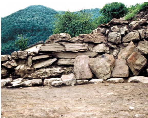
Sl. 11: Hiša 15/2. Obloga iz lapornih plošč ob pregradnem zidu. Fig. 11: House 15/2. Dividing wall with a lining of marl slabs.
