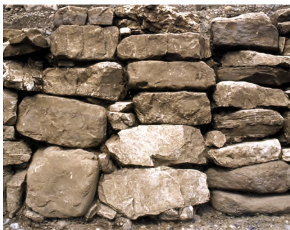
Sl. 10: Hiša 22/1. Detajl severovzhodnega drenažnega zidu. Fig. 10: House 22/1. Detail of the northeast drainage wall.
