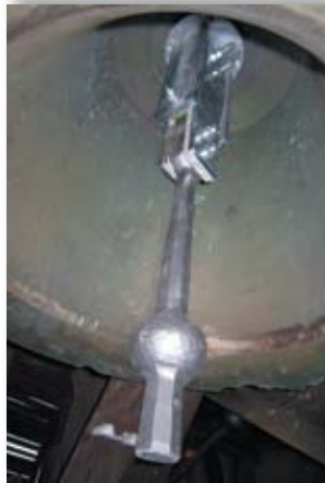
Pregibni kémbelj v zvonu cerkve svetega Danijela, Zgornji Razbor - Slovenj Gradec.
