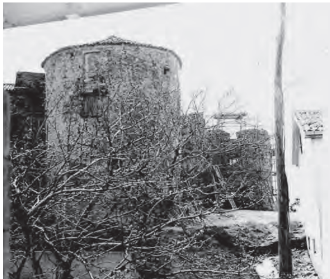
Slika 9: Zahodna stolpa pred obnovo, arhiv ZVKDS OE Nova Gorica.
