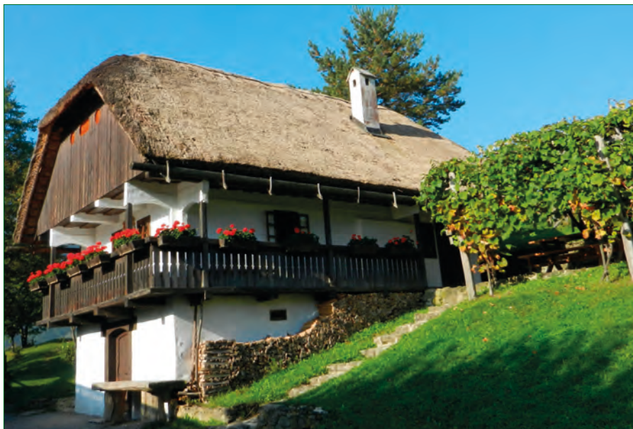
Viničarska hiša z vinsko kletjo v spodnjem in bivalnimi prostori v zgornjem delu. Foto: Primož Pipan.
