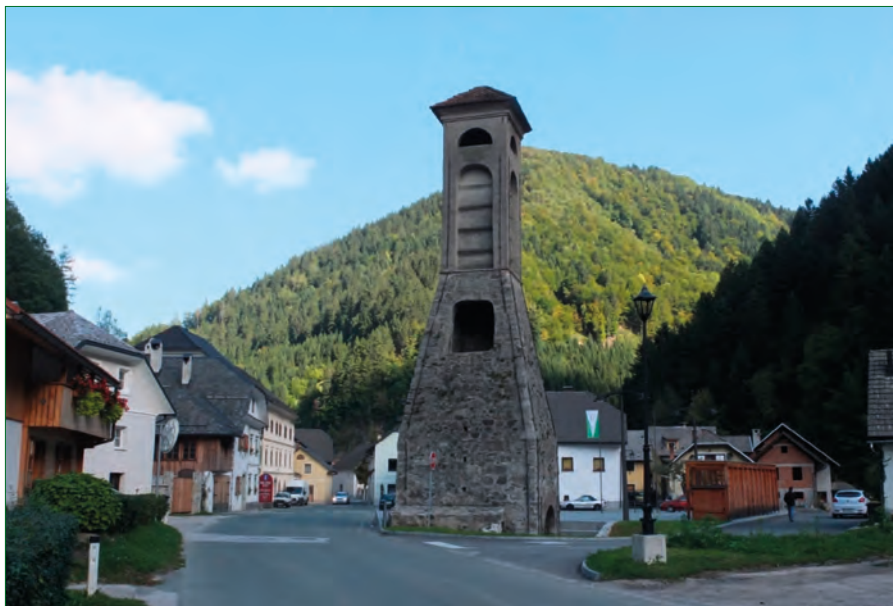
Lepo obnovljen star del Železnikov, imenovan Na Plavžu. Foto: Primož Pipan.
