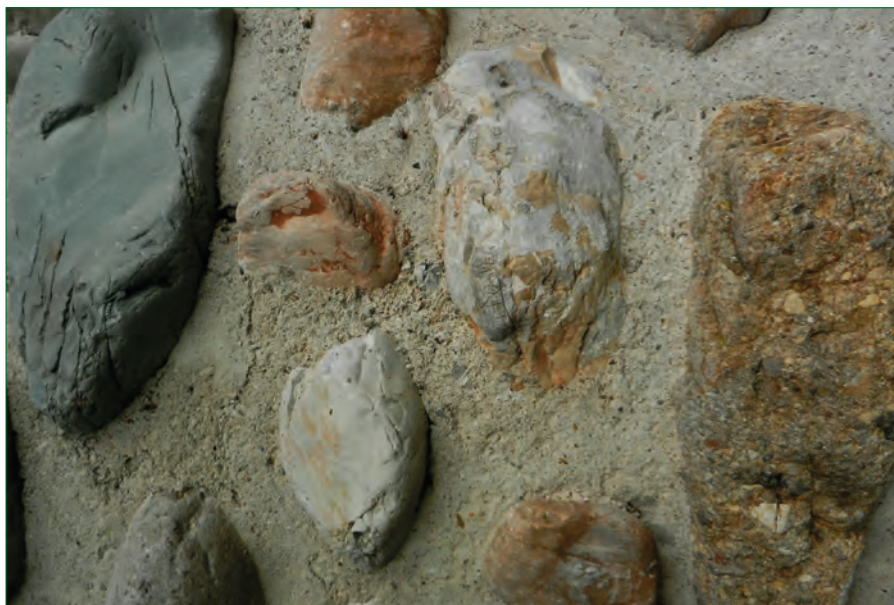
V nosilne stebre strešne konstrukcije spomenika vgrajeni prodniki razkrivajo tamkajšnjo pestro kamninsko sestavo. Foto: Primož Pipan.
