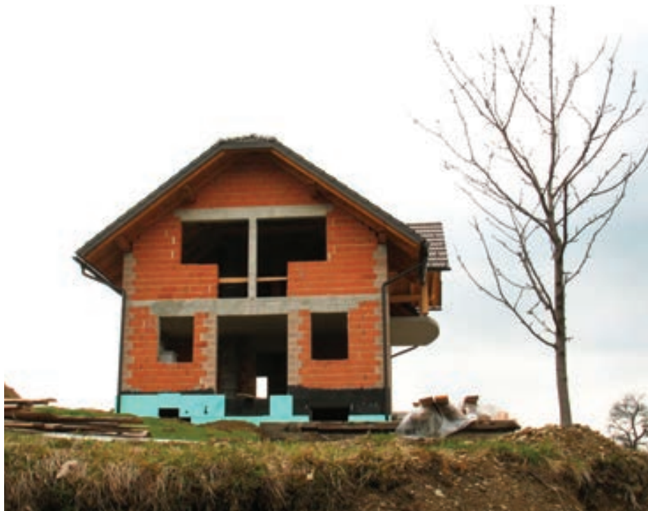
Graditev hiše v Gabrju. 31. 3. 2007.
