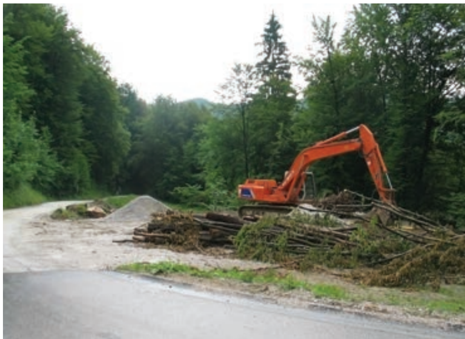
Asfaltiranje ceste od Sostrega do Besnice pod prelazom Pečar. 7. 6. 2009.
