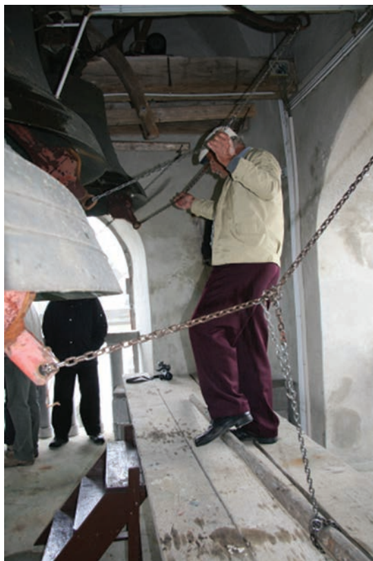
Sl. 11: Namestitev vzvodov pri vodoravni postavitvi zvonov
