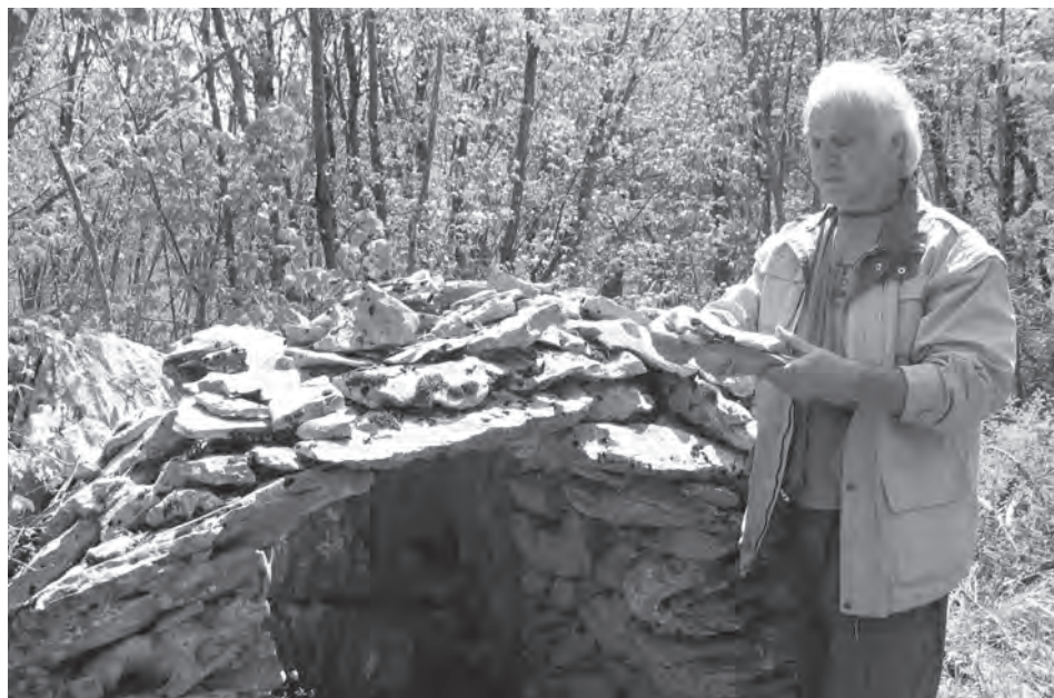
Pastirska dediščina pri vasi Lokve. Vaščan Boris Čok na delavnici Suhi zid na Krasu 2011 predstavlja večšine gradnje kupolastih hišk. (Foto: Jasna Fakin Bajec, 2011.)
