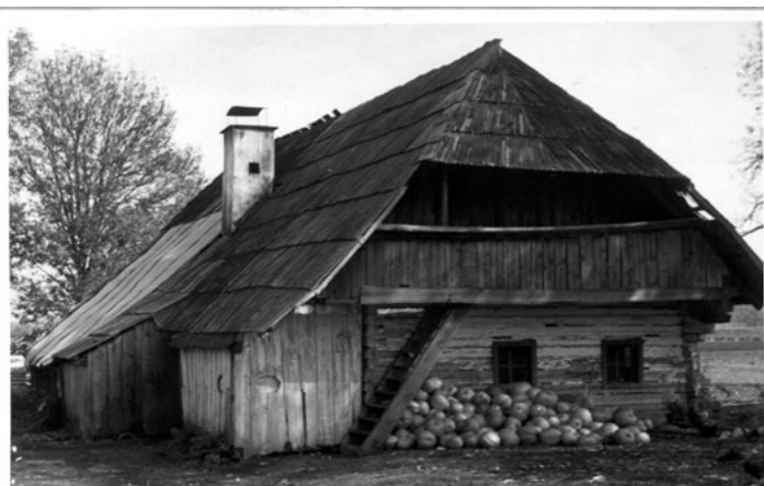
Kazaze/Edling 5 (Podjuna), Fister Valentin, pri Ustar. Del vhodnega (glavnega) in desnega pročelja z »leseno hišo«. Foto Jože Bavdaž (Zasebni arhiv).
