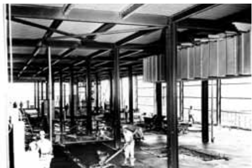
Jeklena konstrukcija stavbe Rocky Flats v Koloradu, ZDA
