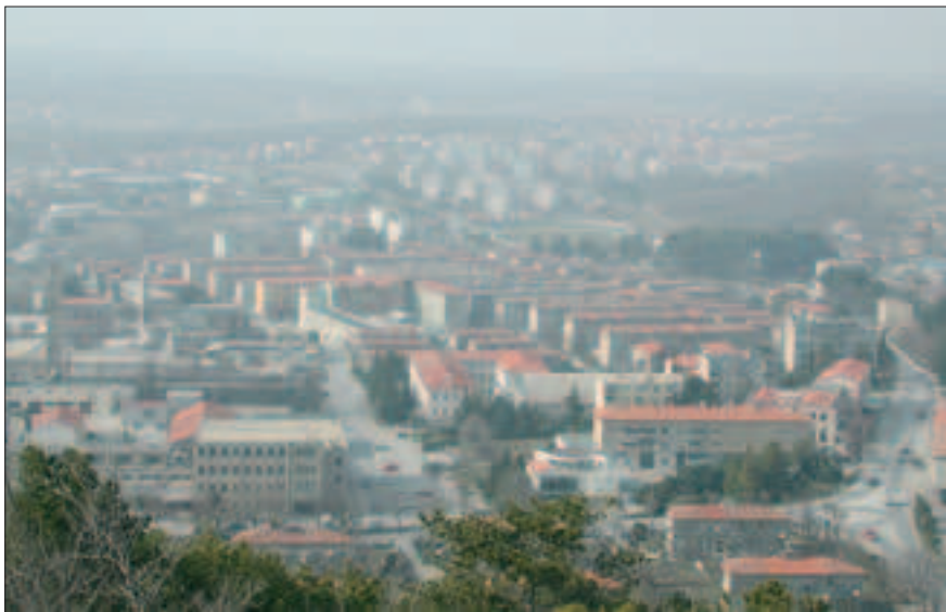
Večji del rudarskih blokov v Labinu je bil zgrajen med svetovnimi vojnami. Foto Primož Pipan.
