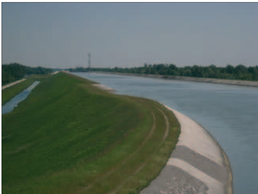
Dovodni kanal in nasip hidroelektrarne Čakovec. Foto Primož Pipan.
