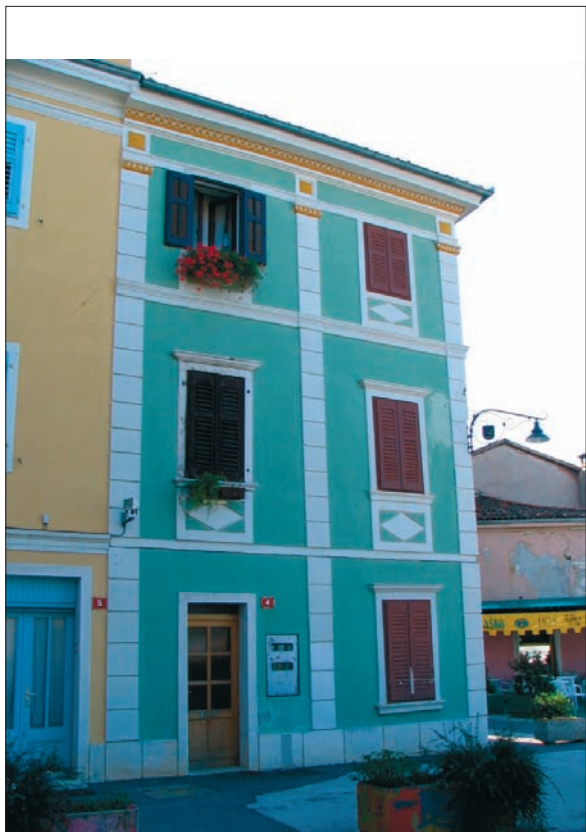
Sl. 2.11.3: Eno od dveh osi prenovljene fasade hiše v Izoli tvorijo slepa okna. Z leti so okna s polkni drugače pobarvali kot slepa.
