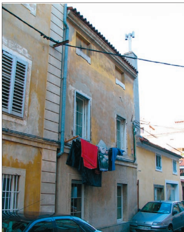
Sl. 2.11.16: Ohranjen primer arhitekturne rešitve dvoosne fasade z atiko v Kopru.
