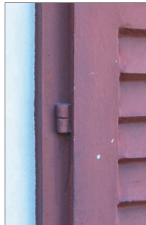
Sl. 2.11.5: Detalj slepega okna nakazuje vložen trud v enoten izgled fasade. Barvni odtenek, vrsta pigmenta, spretnost in način barvanja izdajajo obdobje prenove.
