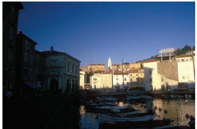
Sl. 2.15.21: Približevanje ožjemu središču po obali z zahodne strani. Dominanta zvonika je skrita za palačami prvega plana, zato nosilka smeri, kompozicije in pomena postane vertikala zvonika samostana. Pod njo je levo spodaj na trgu cerkvice Sv. Petra. Vertikala zvonika je vpeta med stavbama lože na levi in prenovljenega stolpa na desni strani vstopa na glavni trg.
