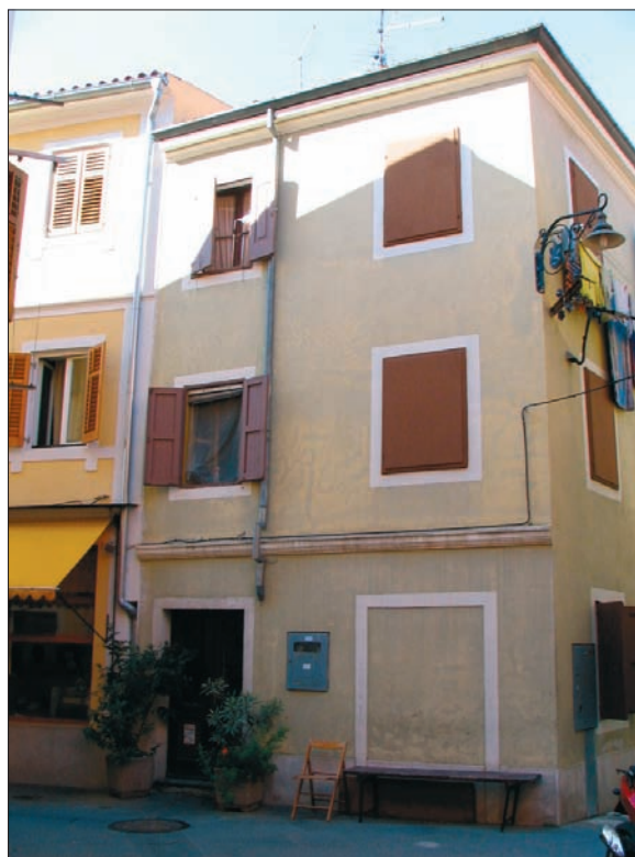
Sl. 2.11.8: Primer fasade s slepimi okni in vrati v Izoli.
