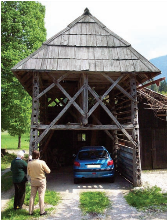
Sl. 1.3.2: Rekonstrukcija bohinjskega stoga
