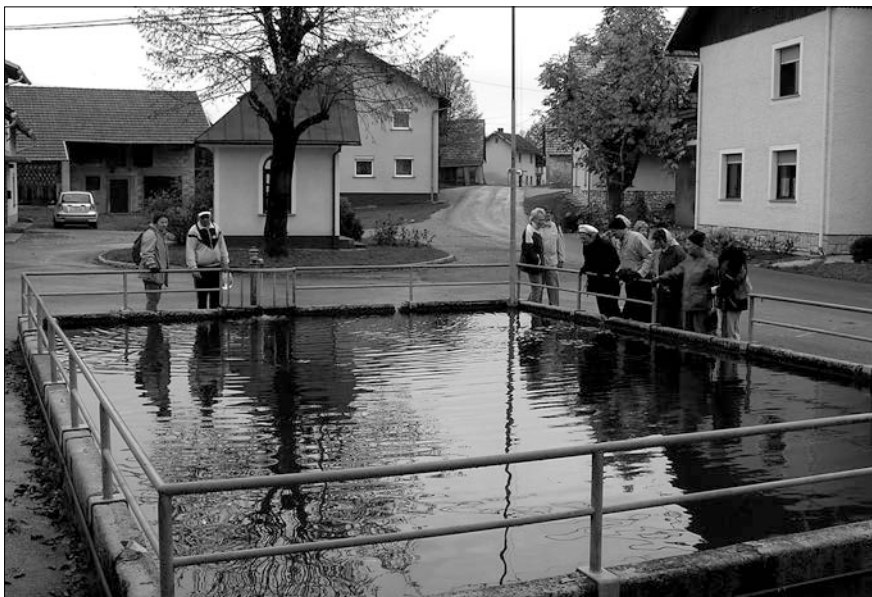
Štirna« v Novi vasi je pomemben vodooskrbni objekt s konca 19. stoletja. Foto Simon Kušar.
