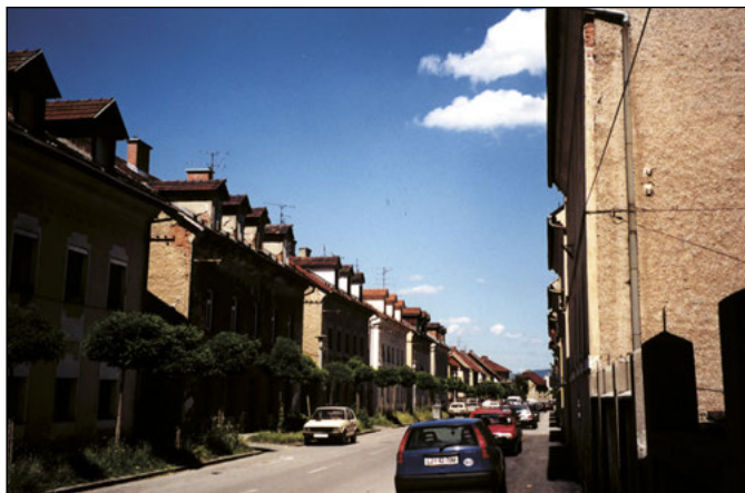
Delavske večstanovanjske hiše na ulici Vide Pregarčeve v Mostah (fotografija D. Rebernik).
