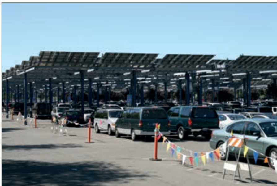
Sončna elektrarna na parkirišču kalifornijskega sejišča v Sacramentu. Foto: Naja Marot.
