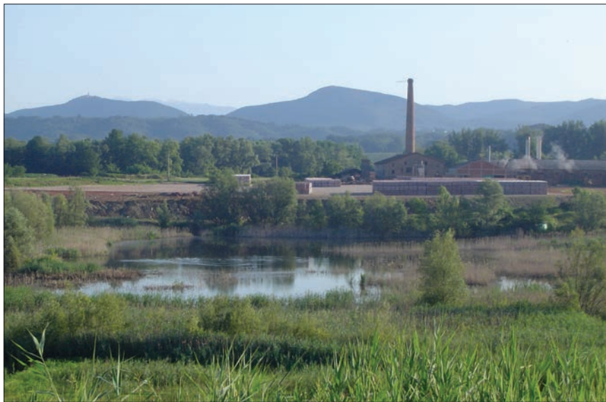
Opekarna Renče z izkopno kotojanjo glinokopa. Foto Branko Pavlin.
