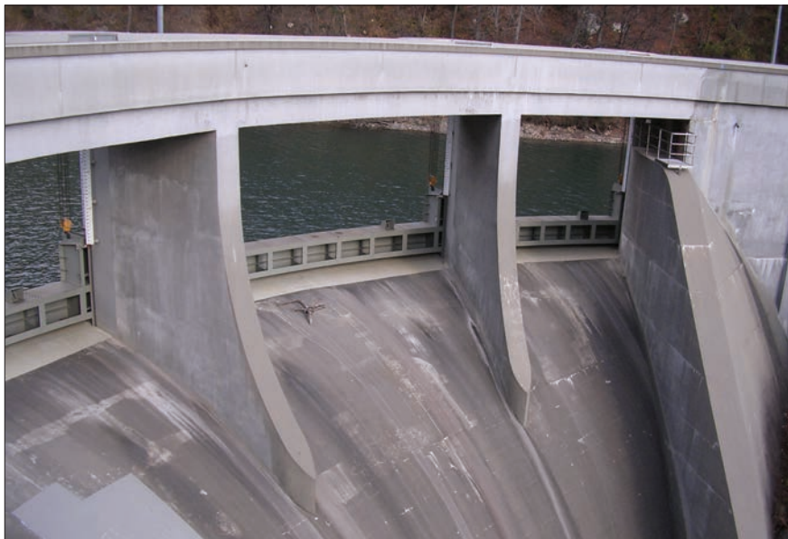
Pregrada hidroelektrarne Moste. Foto Aleksandra Privšek.
