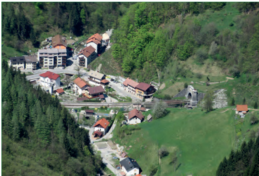
Pogled na spodnji del Podbrda, kjer bohinjska proga izginja v predoru. Foto: Primož Gašperič.
