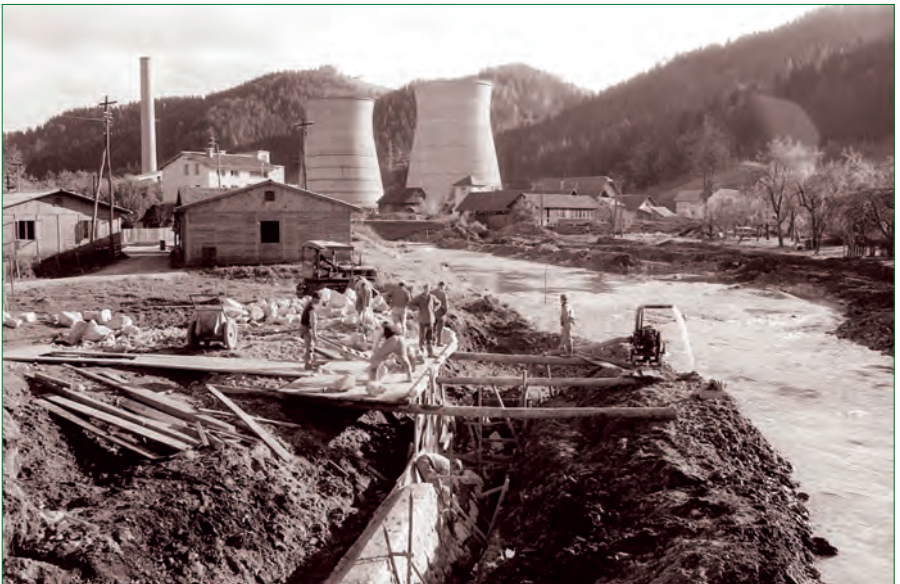
Pogled na šoštanjsko termoelektrarno leta 1960. Foto: Wikimedia Commons.
