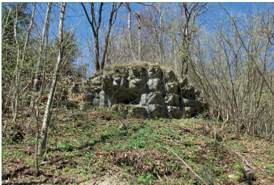
Samostojni bojni blok brez jeklenih delov. Foto: Primož Gašperič.
