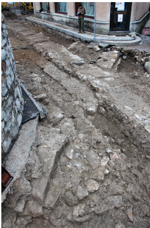
Sl. 5: Ajdovščina. Pogled na del obzidja ob stolpu 12, ki je bil poškodovan z novodobno kanalizacijo. Pogled proti severovzhodu.
