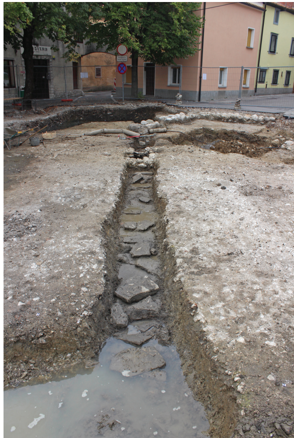
Sl. 11: Ajdovščina, severozahodni del Lavričevega trga. Pokrovne kamnite plošče kanalizacijskega kanala, ki je potekal vzporedno s cesto faze 1.
