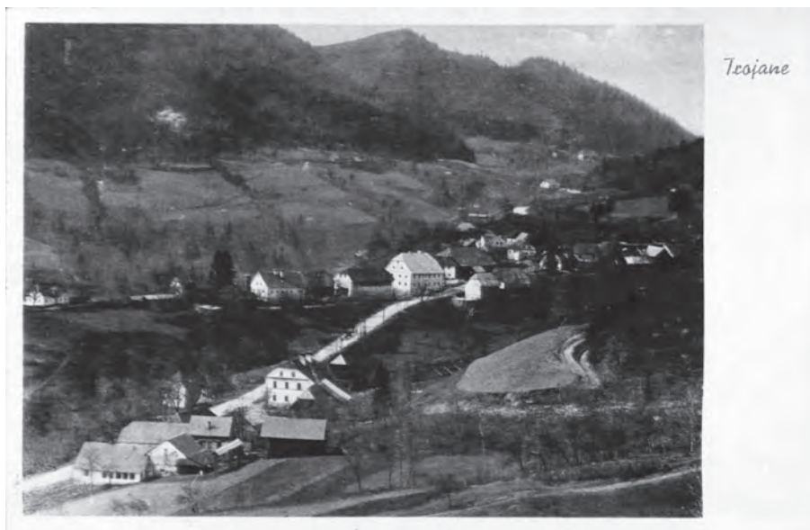
Sl. 19: Trojane. Pogled proti zahodu. Posnetek je nastal najpozneje leta 1943. (Vir 7).
