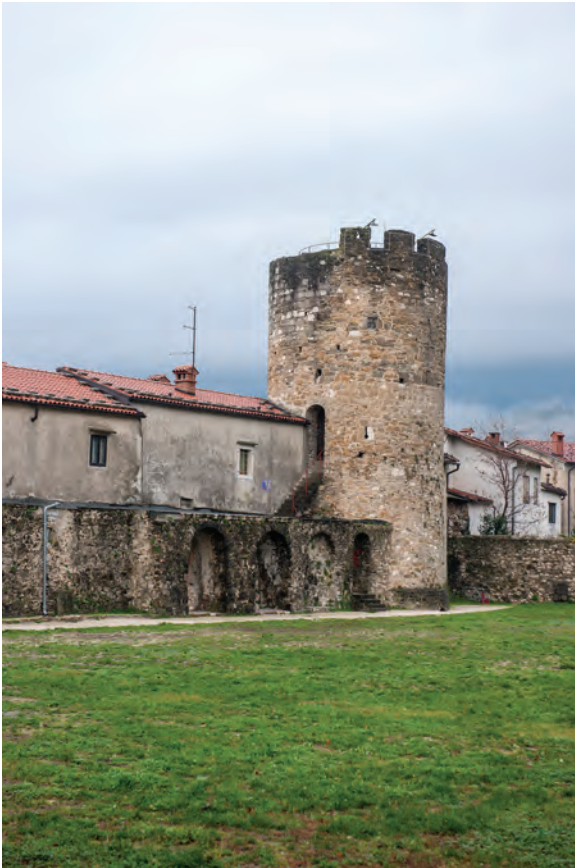
Sl. 4: Ajdovščina, pogled na vzhodno obzidje utrdbe, stolp 8. Fig. 4: Ajdovščina, view on the eastern fortification wall, Tower 8. (Foto / Photo: Anton Tratnik)
