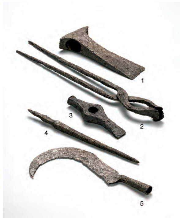
Sl. 13: Ulaka. Schmidova izkopavanja, Hiša 5 / Kovačnica A. Železno orodje: 1 – sekira (d. 22,7 cm); 2 – klešče (d. 46,4 cm); 3 – kladivo (d. 17,2 cm); 4 – pila (d. 30,8 cm); 5 – vejnik (d. 26,4 cm). Vse predmete hrani NMS.
