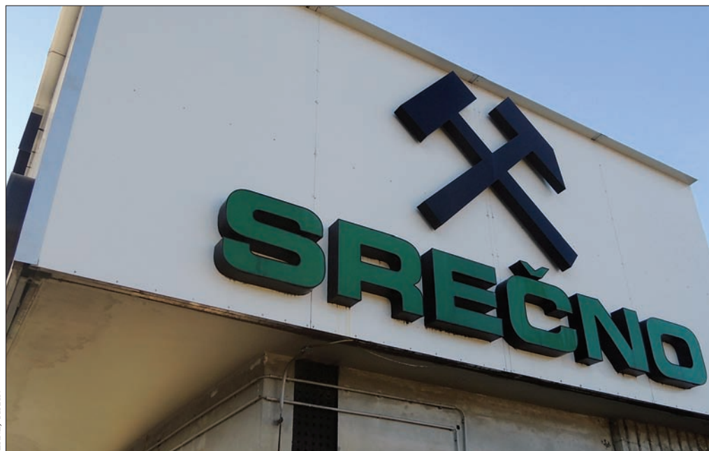
Slika 11: Na strehi ene od tako imenovanih rudarskih stolpnic v Velenju je okoli strojnice dvigala oblikovan pano z napisom »Srečno« in rudarskim znakom.
