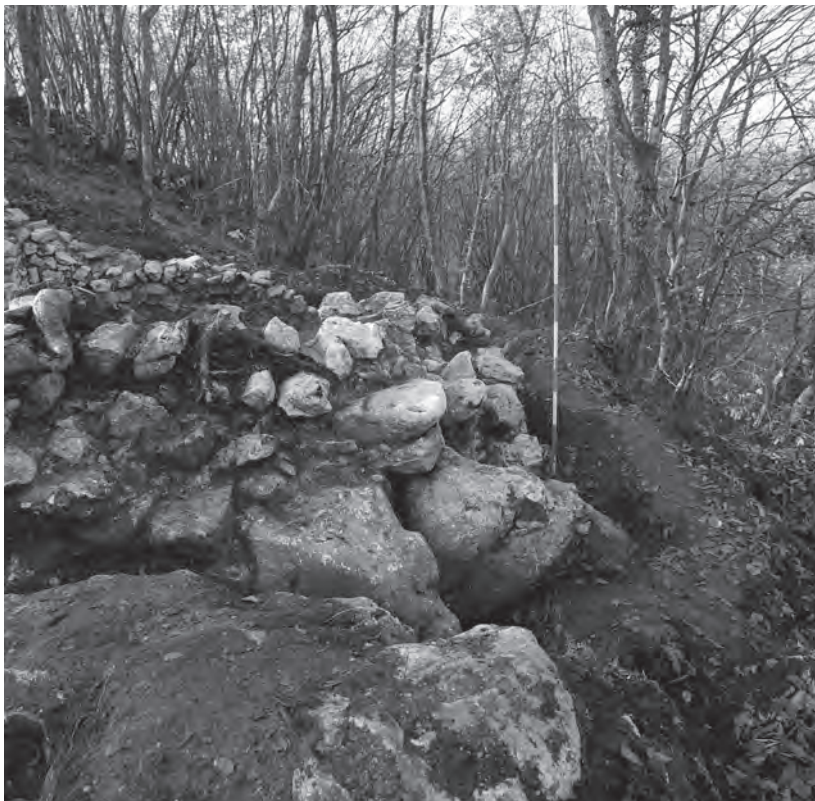
Sl. 2.8: Stolp 1, temelj zidov 1 in 2. Pogled proti jugozahodu.
