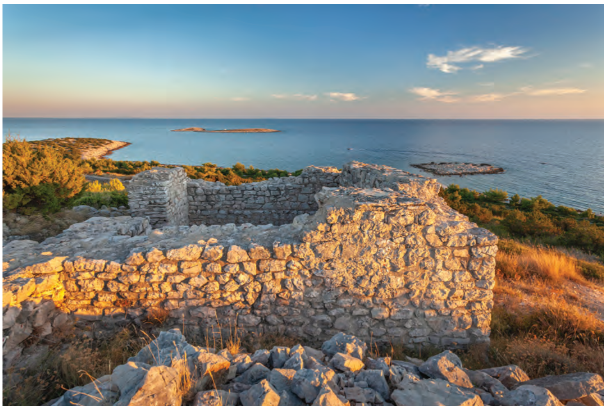
Sl. 9.3: Žirje, Gradina. Stolp na jugovzhodni strani utrdbe.
