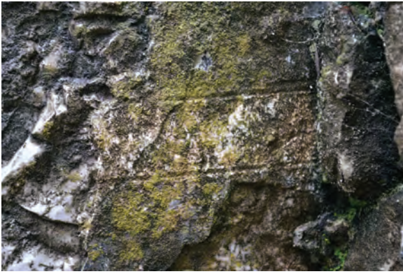
Sl. 14.10: Ostanke ometa na notranji strani zidu zvonika (SE 12).
