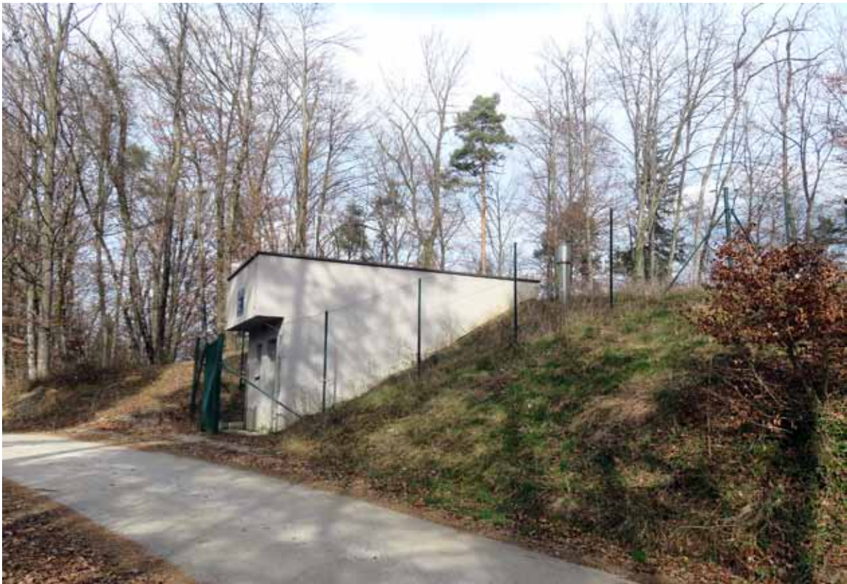
Sl. 293/2: Vidmarjeva hosta nad Ribjekom; območje vodohrana, pogled z jugozahoda. Foto: Janez Dular (2020).
