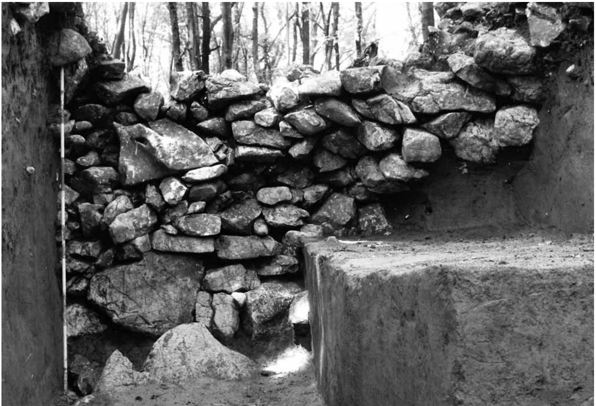
Sl. 273/7: Kunkel pod Vrhtrebnjem; zunanja fronta 2. zidu. Foto Borut Križ (1988).
