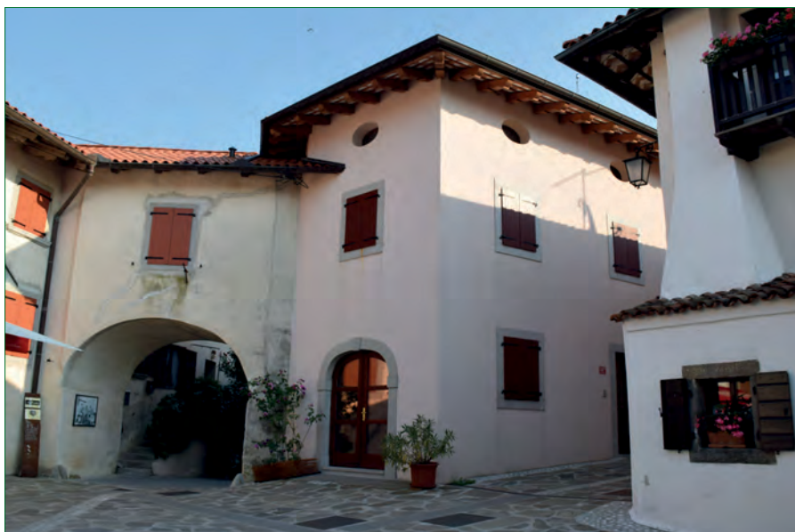
Hiše v Šmartnem so praviloma zgledno obnovljene. Foto: Maja Topole.
