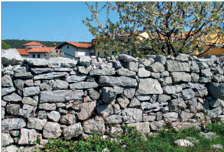
Značilen suhi zid v Lokvi na Krasu. Foto: Jasna Fakin Bajec.
