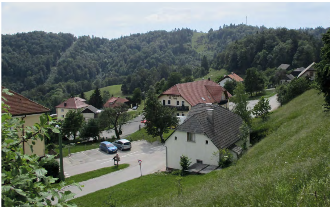
Pogled na »Čopov del« Podkuma; v sredini novo gostišče »Pr' Čop«, desno Čopovina, nekdanji dvorec Podšentjur (foto: B. Golec, avgust 2018).
