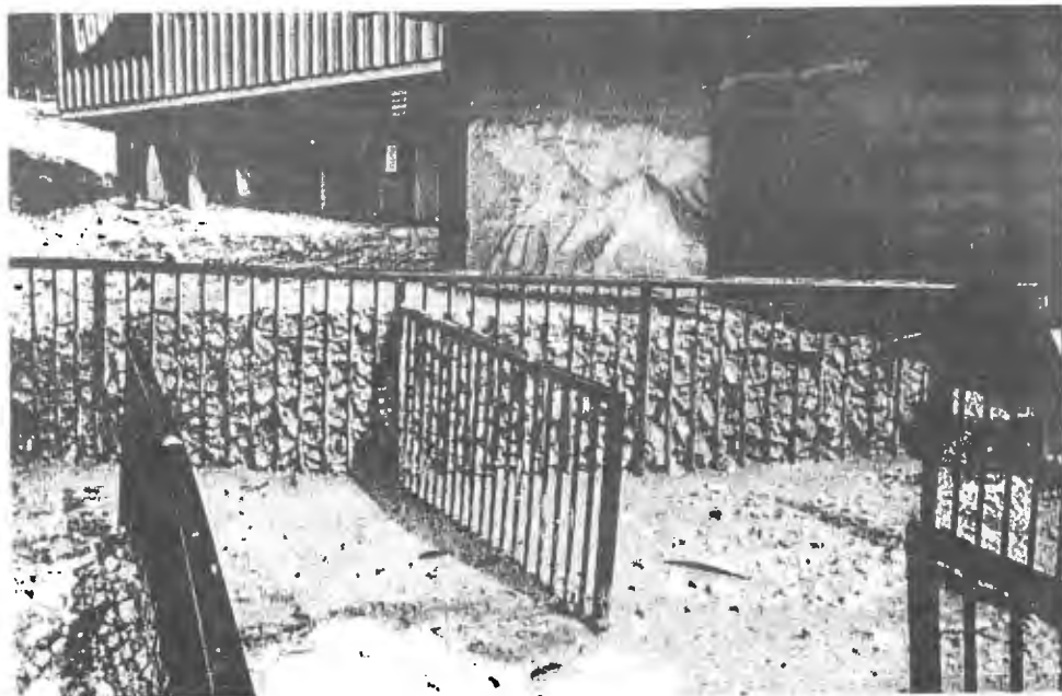
RTC Krvavec - ograja za vrsto čakajočih ob pristopu h gondolam kot naključna pregrada za zadrževanje hudourniške lave kaže "profil" slednje. (1991, foto: M. Zemljč)
