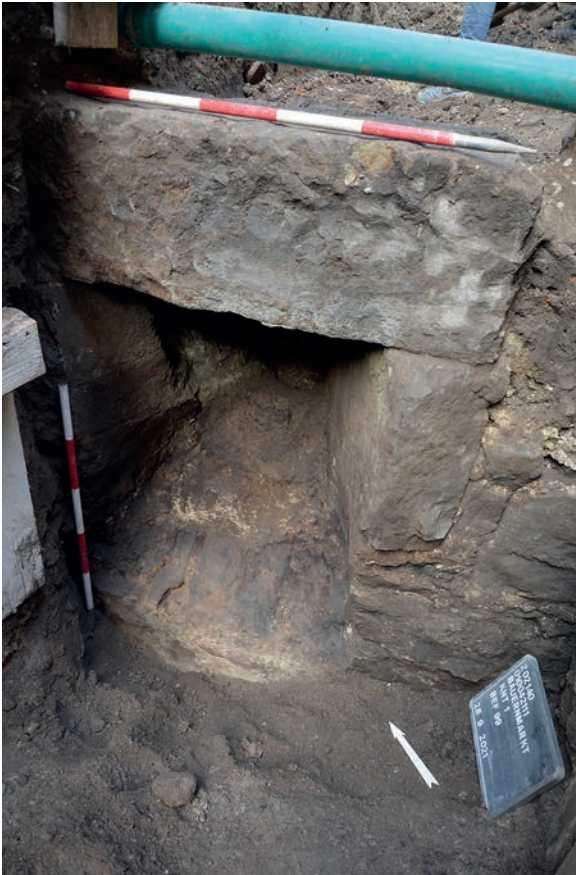
Fig. 5: Römisches Kellerfenster an der Nordseite eines Sondergebäudes ( horreum? ) im Legionslager Vindobona. Fundstelle Wien 1, Bauernmarkt, vor Nr. 1 (Foto: Stadtarchäologie Wien).
