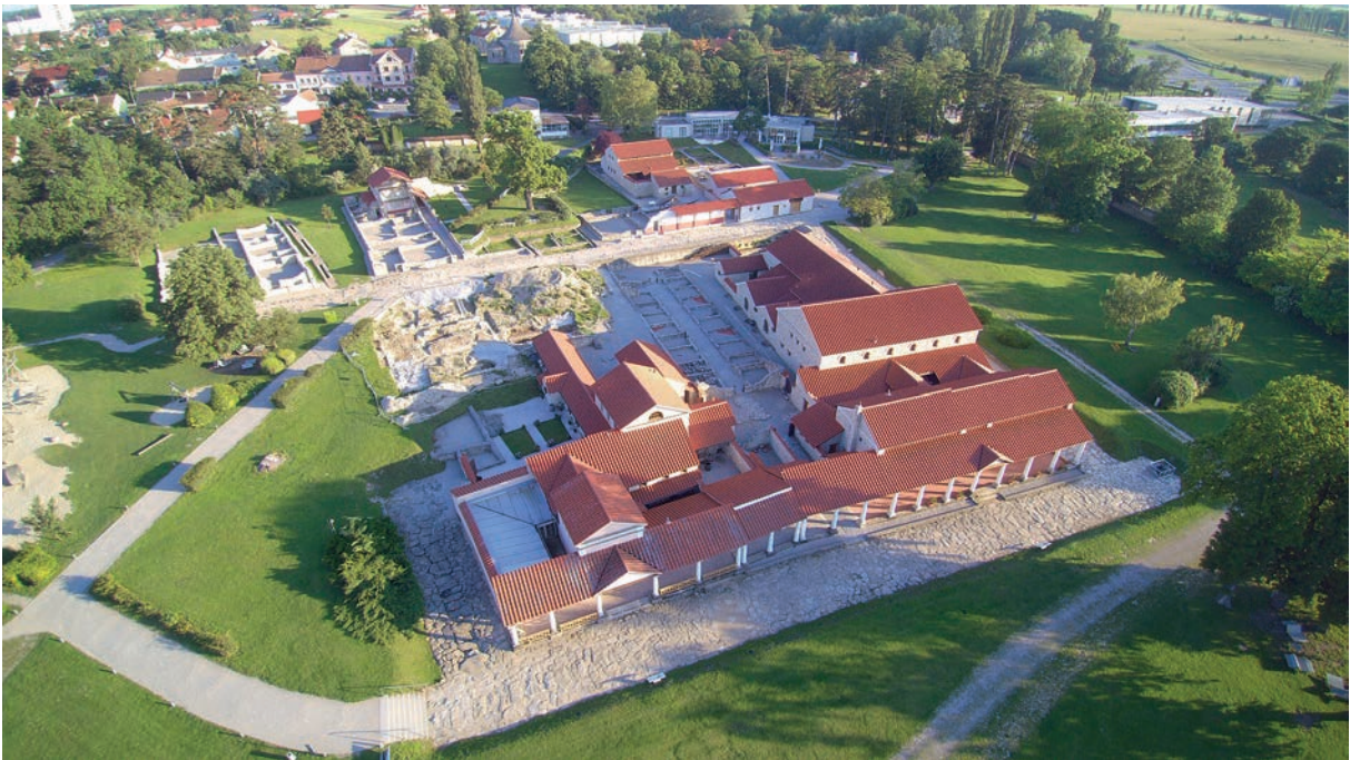
Abb. 12: Römerstadt Carnuntum, rekonstruiertes Stadtviertel im Südosten der Zivilstadt, Ansicht von Norden. Mittig am oberen Bildrand ist die romanische Rundkapelle zu sehen. – © H. Schneider (Petronell-Carnuntum).
