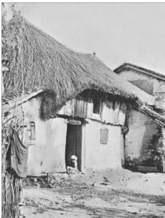
Slika 1: Primer kmečke hiše v furlanskem delu Goriške in Gradiške. Stanovanjski objekti so bili še konec 19. stoletja velikokrat kriti s slamo ter brez tlaka, ločenih prostorov, ustreznega prezračevanja, ogrevanja in dostopa do svetlobe (Caprin, Pianure friulane , str. 249).
