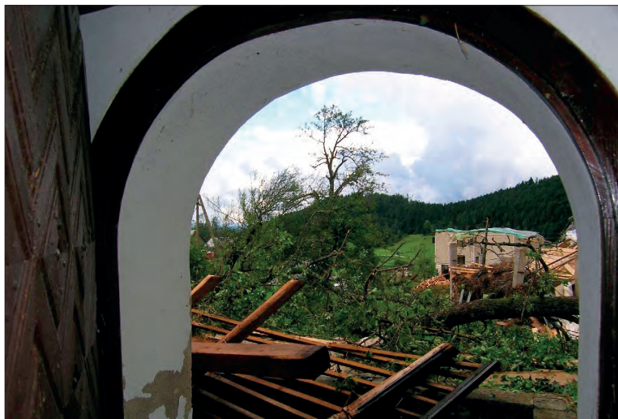
Pogled na posledice vetrovne ujme 13. julija 2008 v vasi Gozd nedaleč od Črničve. Foto: Blaž Komac.
