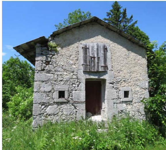
Portal v pročelju samostojne kleti na domačiji pri Medvedu v Lokovcu, sestavljen iz različno velikih klesancev in masivne preklade
