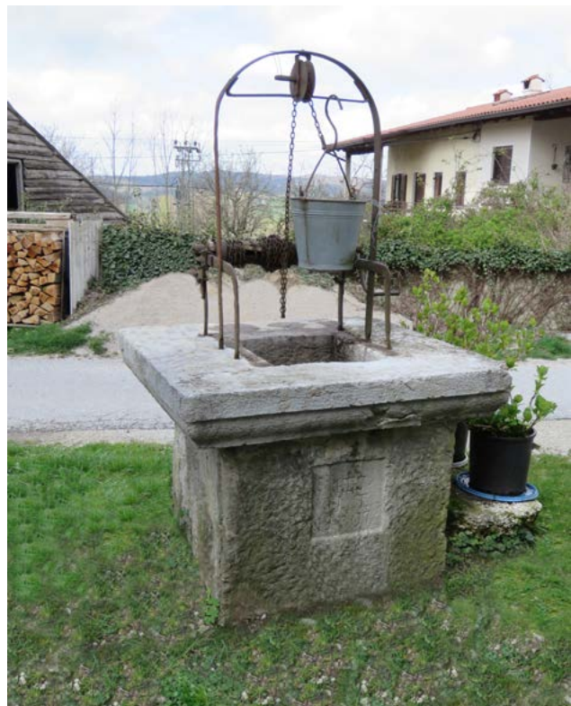
Vodnjak pri Blajščih v Krvavcu, opremljen z vretenom in škripcem, na katerega je obešena kibla ali kajngla
