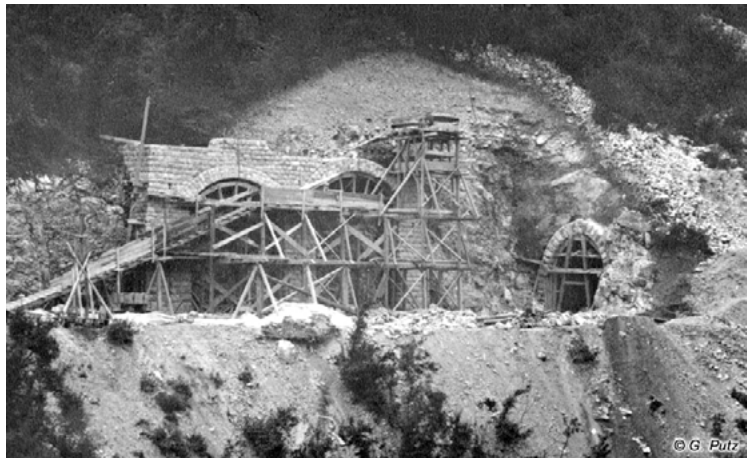
Gradnja vhoda v predor Avče. Arhiv Tolminskega muzeja, album Gerharda Putza
