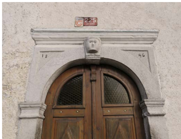
Gornji del hišnega portala pri Hilarju s polkrožnim lokom, figuralnimi sklepnim kamnom, nadločjema in simsom
