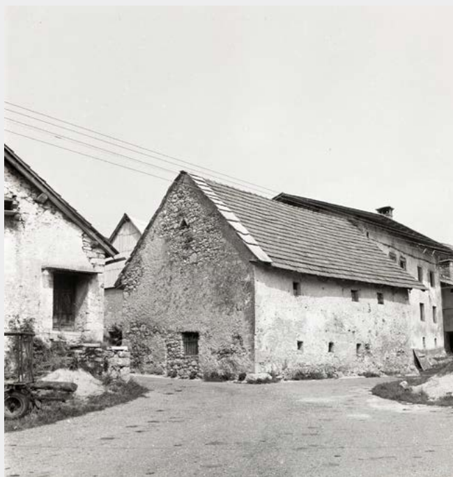
Skrile na svisljih štale pri Andrjaču v Tolminskem Lomu. Fototeka ZVKDS, območna enota Nova Gorica
