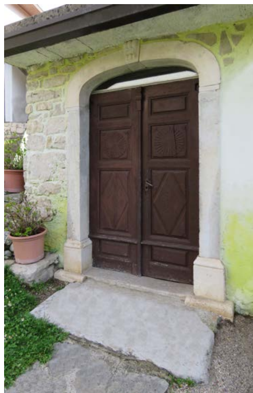
Hišni portal s potlačnim košarastim lokom pri Matičevih v Grgarskih Ravnah, ki ima na sklepnem kamnu letnico 1903
