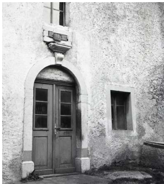
Nekdanji hišni portal pri Ščurarju s polkrožnim lokom, volutnim sklepnim kamnom in simsom. Fototeka ZVKDS, območna enota Nova Gorica
