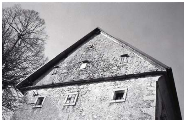
Fasadne odprtine v zatrepni steni Hilarjeve hiše v Lokovcu: čim višje so, tem manjše in skromnejše so. Nad majhnimi okni s klesanimi oknjaki v nadstropju, ki ga od zatrepa ločuje skrilnat venec, so grobo oblikovana podstrešna okenca s skrilnatimi napušči, v vrhu zatrepa pa je preprosta trikotna podstrešna line, značilna za stavbe na celotnem obravnavanem območju.
