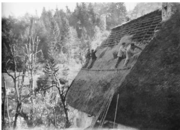
Levo: streharji trgajo preperelo slamo s strehe hiše V Dolini, Lokovec 213, okrog leta 1960. Prvi z desne je verjetno Jože Rijavec - Klanfar. Fotografijo hrani Roman Rijavec v Lokovcu. Desno: glavnik in prtiskavka za slamo iz muzejske zbirke pri Klanfarjevih v Lokovcu
