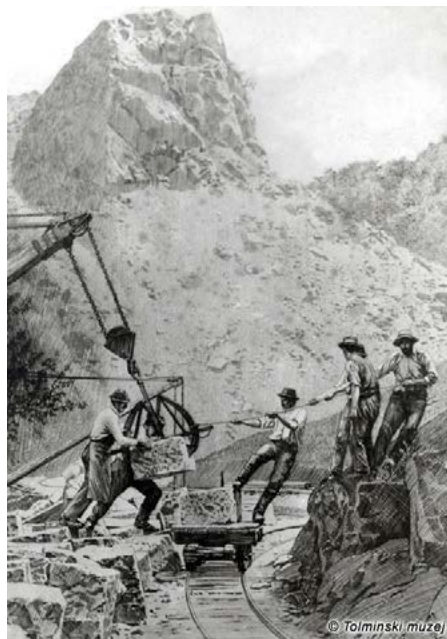
Dviganje in nakladanje težkih kamnitih blokov s kleščami za kamen. Umetnostno-zgodovinska zbirka Tolminskega muzeja
