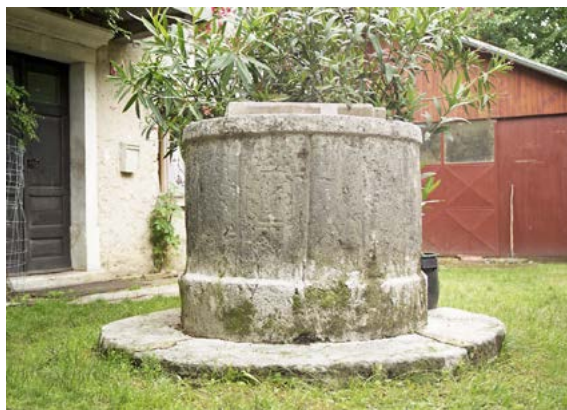
Valjasti oklep vodnjaka pri Kolčevih v Podlaki z letnico 1909 in inicialkama kamnoseka Franca Petrevčiča. Fototeka ZVKDS, območna enota Nova Gorica
