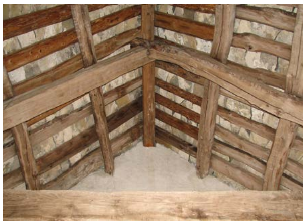
Levo: škarjasto povezje s prekrizanimi škarnikoma nad vhodno lopo cerkve sv. Tomaža. Desno: edini doslej odkriti kamnoseški znak na temenu slavoloka prezbiterija v tej cerkvi
