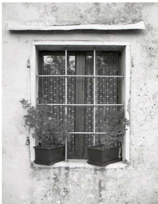
Okno z ozkimi lici oknjakov v novejšem krilu domačije Pod Školjem v Sedovcu
