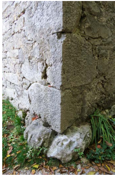
Robustni odbijač naravnih oblik v vogalu obcestne stavbe na domačiji pri Gulinih v Podlaki
