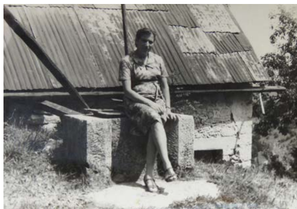
Krniž vodnjaka pri Šmonu, v katerega je bila strešnica speljana po lesenih žlebovih
