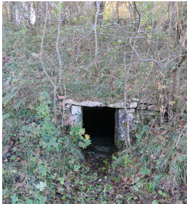
Zdenec v Zaklancu pri Zabrdi, obdan z velikimi skrilami
