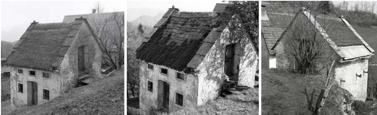
Klet pri Grgurju v Lokovcu, ki je prvotno imela slamnato streho s skrilami na svislih in strešnem kapu. Slamnata kritina je sčasoma propadala, nato je bila deloma in nazadnje v celoti nadomeščena z valovitimi salonitnimi ploščami. Fototeka ZVKDS, območna enota Nova Gorica
