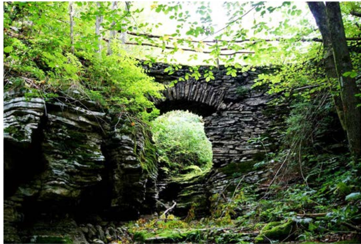
Izjemna skladnost dela narave in človeka: most iz skril na skrilnatih skladih v Kremencah na območju Tolminskega Loma
