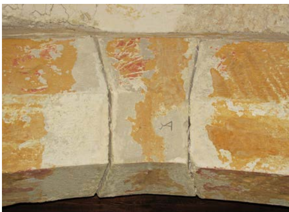
Levo: škarjasto povezje s prekrizanimi škarnikoma nad vhodno lopo cerkve sv. Tomaža. Desno: edini doslej odkriti kamnoseški znak na temenu slavoloka prezbiterija v tej cerkvi
