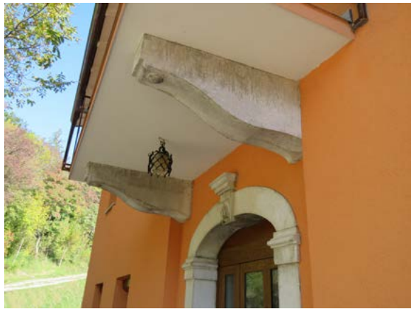
Gosposki balkonček na paru profiliranih konzol nad hišnim portalom pri Lašču v Bitežu
