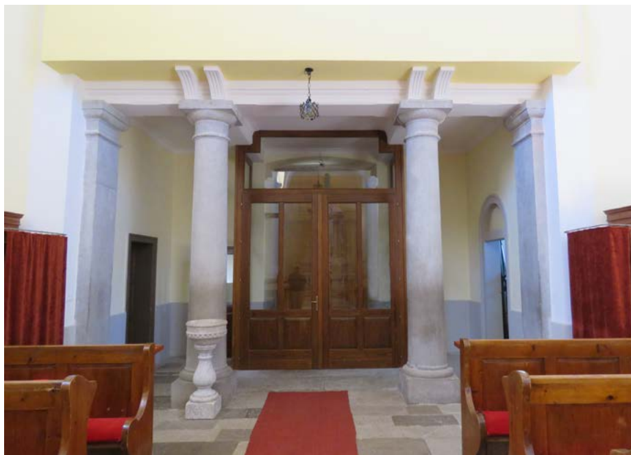
Visoki monolitni koloni pod pevskim korom v cerkvi Marije Snežne na Trnovem, za kateri so kamen lomili v gmajni Na Dečli
