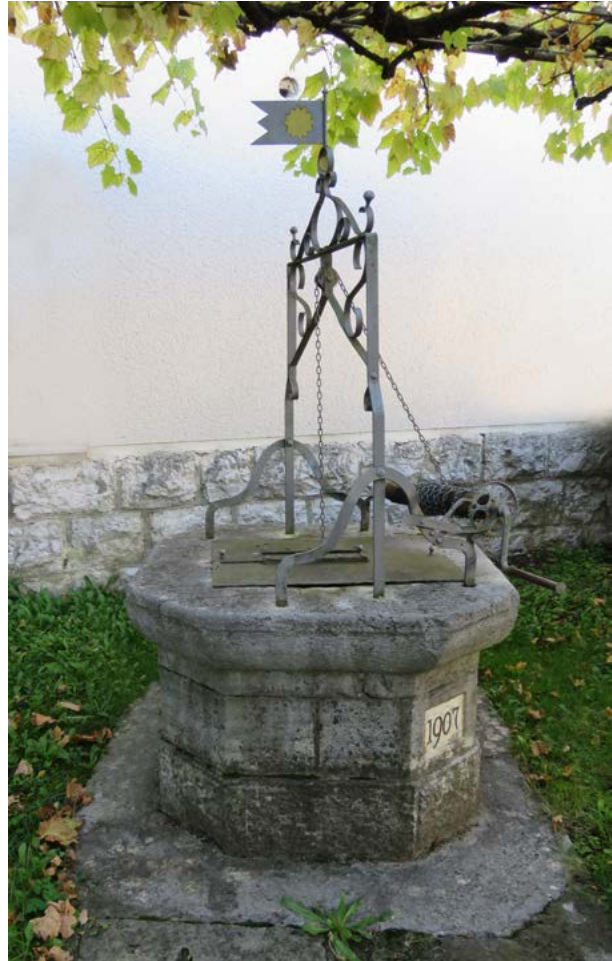
Osmerokotni oklep štjerna pri Zorčevih z letnico 1907, sklesan iz enega kamna. Štjern je zdolaj kvadratast, volt pa je okrogel. Zraven je bilo korito, v katerem se je pojila žival. Ker je med prvo vojno v štjern padla granata in ga poškodovala, so bratje Zorčevi po vojni volt naredili na novo.
