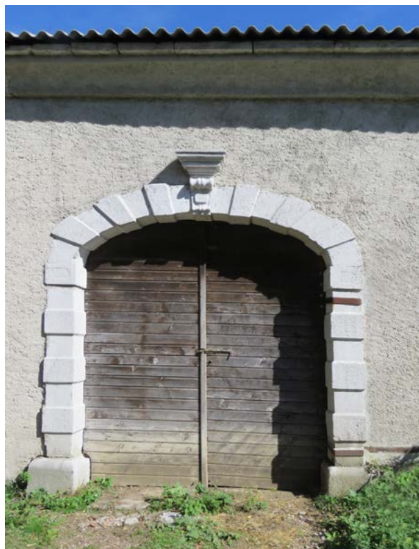
Edinstveni gosposki porton rustikalnega tipa s potlačenim lokom na domačiji pri Gulinih v Podlaki
