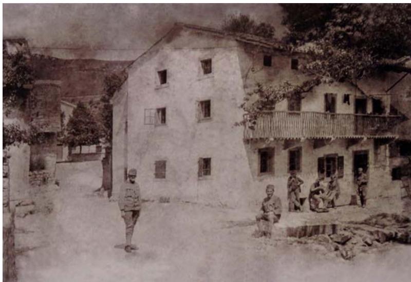
Hiša pri Hubjanih v Batah med prvo svetovno vojno, ko je imela še lesen gejnkm na kamnitih konzolah in na desni s slamo krito štalo. Fotografijo hrani Silverij Fabjan pri Hubjanih v Batah.
