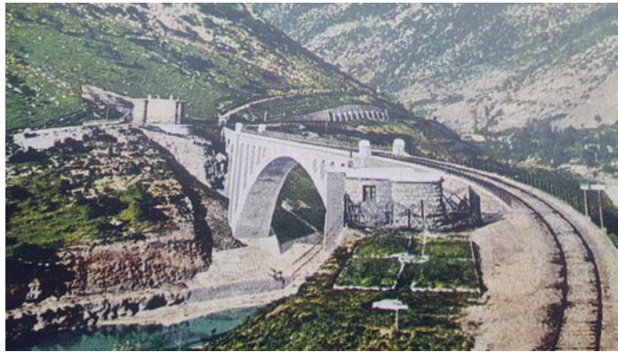
Razglednica solkanskega mosta, posneta takoj po njegovem odprtju; skrajno desno je videti kamnolom. Zasebni arhiv Gorazda Humarja iz Šempetra
