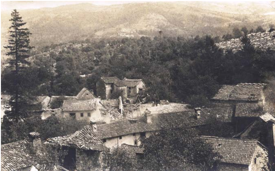
Skrilnate in slamnate strehe v grgarskem zaselku Dol, posnete med prvo svetovno vojno. Iz zbirke Egona Valantiča v Novi Gorici
