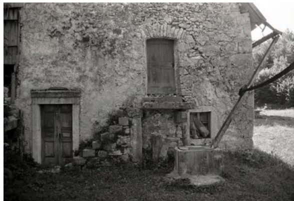
Nekdanji kamniti gejnk pred zatrepno fasado pri Jakopcu v Lokovcu, ki je slonel na vrhnji konzolni stopnici, podprti s klesanim slopom, in na konzoli
