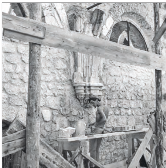
8. Dopolnjevanje manjkajočih delov na konzoli v južni ladji samostanske cerkve, 1964 (© Republički zavod za zaščito spomenika kulture – Beograd; foto: Milka Čanak)
