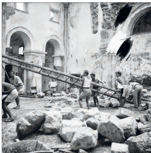
7. Očiščevalna dela v samostanski cerkvi (© ZRC SAZU, fototeka UIFS)
