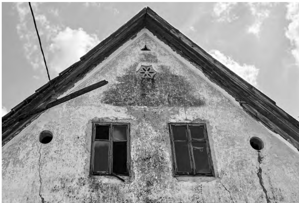
Na nekaterih hišah na Kočevskem, kot je primer iz Drage na sliki, so še ohranjene podstrešne line. Foto: Anja Moric, avgust 2024.
