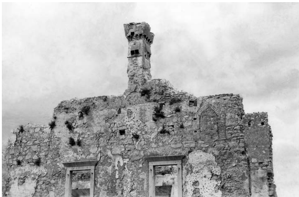
Slika 2: Dvoriščna fasada severnega palacija pred porušitvijo. Vidno je zazidano romansko okno (© ZVKDS OE Nova Gorica).
