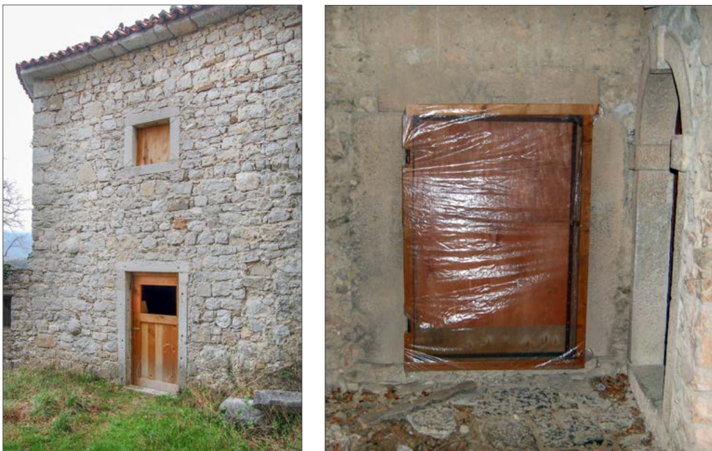
Slika 5: Zaprta okna in delno zaprta vrata rondela 19 (18. 4. 2008) (levo) ter zastrt in zaprt vhod v vhodni stolp (16. 4. 2009) (desno) (© Arhiv ZRSVN; foto: Klavdij Bajc)
