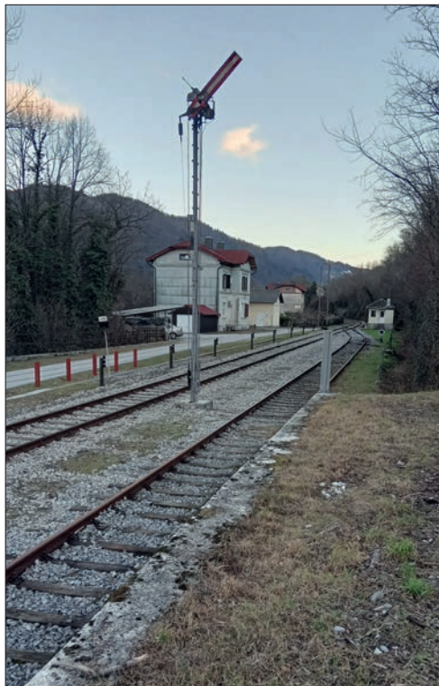
Slika 1: Mehanski signal in kretniška postavljalnica na postaji Most na Soči.
