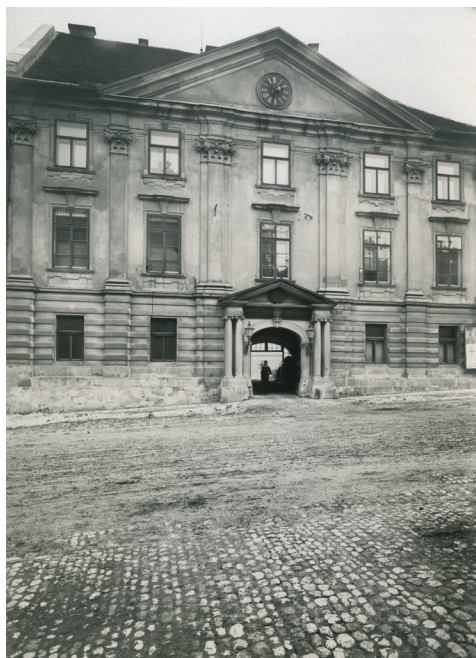
Lontovž, palača Kranjskih deželnih stanov, leta 1910, danes sedež SAZU (Vir: Zgodovinski arhiv Ljubljana)
