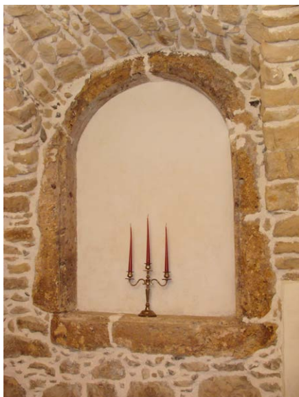
Portal v kleti ene od hiš na Šutni v Kamniku, odkrit ob obnovitvenih delih, kaže na spremembo nivoja tega dela mesta. (Foto Marija Klobčar, 2015)
