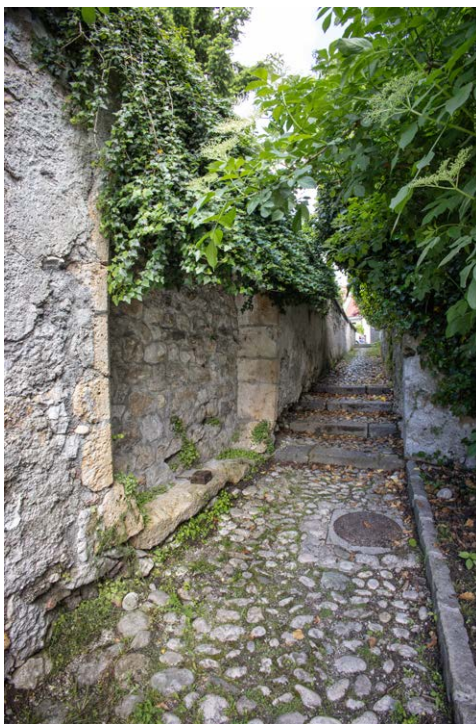
Vrata v škarpi, ki na videz ne vodijo nikamor, nakazujejo nasutje, razvidno tudi iz podzemnih prostorov pod pomožnim objektom kamniškega župnišča. (Vrata v vzhodnem delu škarpe župnišča; foto Marko Zaplatil, 2025)
