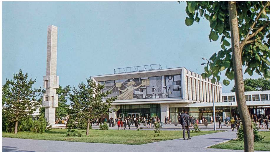
Figure 10. Cinema building, Țiglina district, Galați, 1962. Source: Digital Archive of the Union of Architects of Romania, © Uniunea Arhitecților din România.
