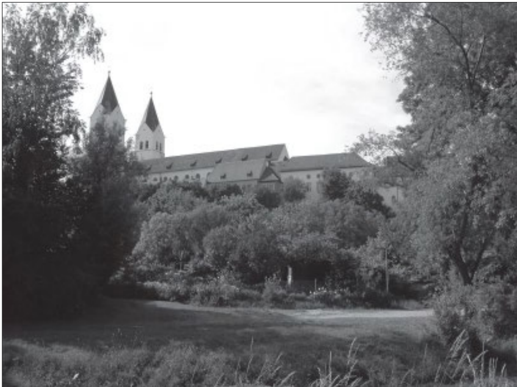
Das archiv des Domkapitels über dem Südflügel des Domkreuzgangs
