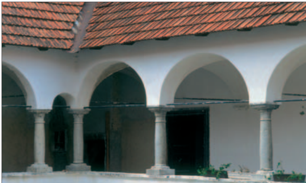
Slika 182: Grad Tušanj ima štiriraktno zasnovo. Pravokotno notranje dvorišče z vodnjakom obdajajo križnogrebenasto obokani arkadni hodniki. Del dvorca je bil v devetdesetih letih obnovljen in namenjen kulturnim prireditvam.
