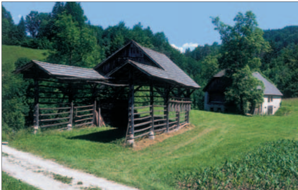
Slika 183: Lega Moravske doline v zatišju glavnih prometnih tokov je pripomogla k ohranitvi mnogih prvih etnološke dediščine. Na sliki so gospodarska poslopja pri Rožeku.
