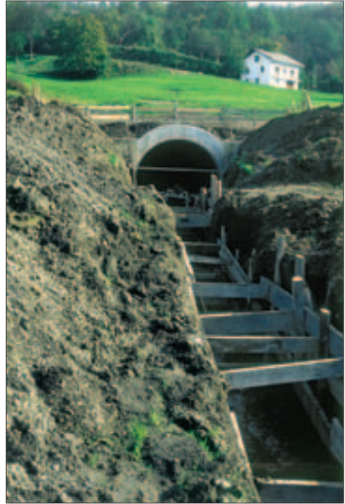
Slika 29: Razbremenilna cev odvaja vodne viške iz doline Radomlje v dolino spodnje Drtijiščice in povzroča v enem delu stalno, v drugem pa občasno ojezerjenost.
