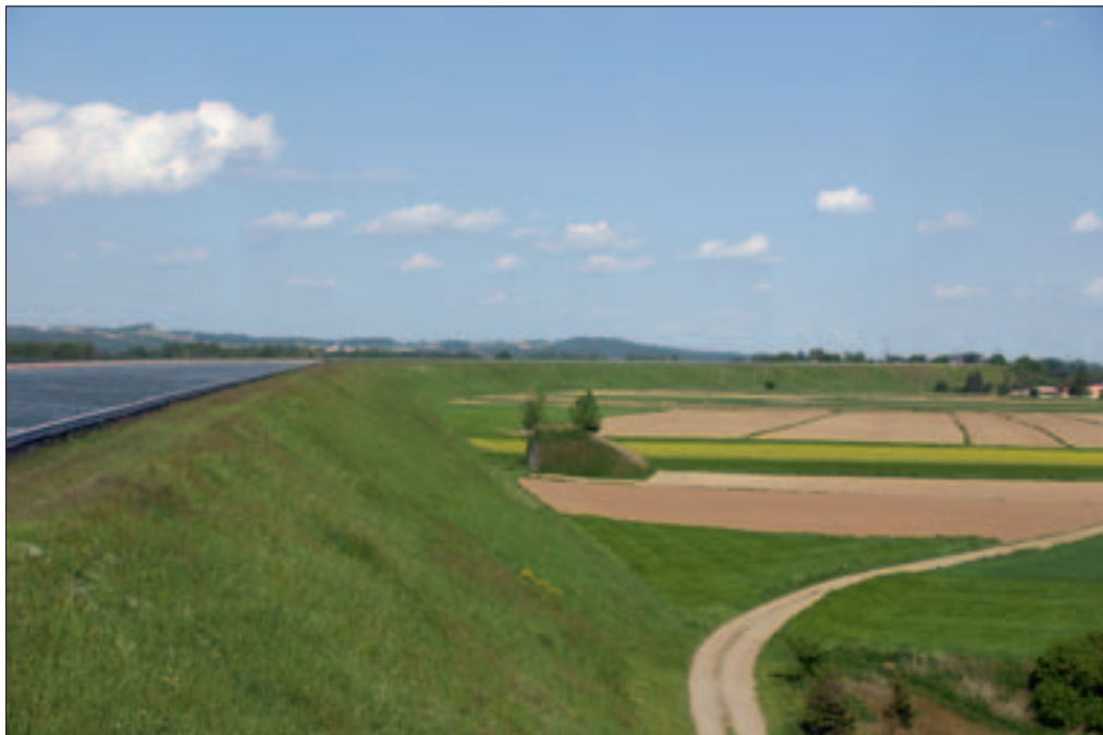
Slika 100: Nasip dovodnega kanala HE Formin sega osem metrov nad raven Ptujkega polja.
