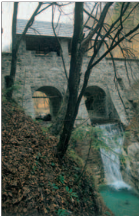
Slika 112: Klavže, dolinske zapornice na Idrijci in njenih pritokih, so omogočale zajezitev voda in plavljenje lesa ob nizkem vodostaju.
