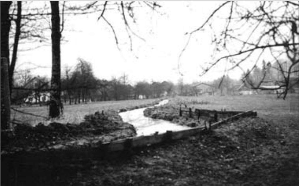
Slika 67: Še v sedemdesetih letih prejšnjega stoletja so obrečne travnike nad Žimentovim mlinom v Nasovčah zavarovali z deskami in nasipi iz zemlje (Radinja in ostali 1973).
