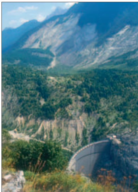
Slika 115: Betonski jez v dolini Vajont je zdržal pritisk 70 m visokega pljuska vode, ki je nastal po zdrsu zemeljskega plazov v tedanje akumulacijsko jezero, in je v dolini Piave povzročil pravo opustošenje.
