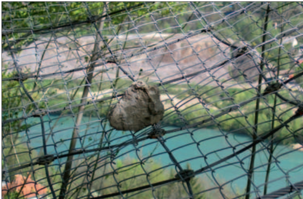
Slika 123: Žična pregrada varuje avtocesto pri Jesenicah pred padanjem skal, bližnje podobne naprave pa so namenjene tudi za varstvo pred snežnimi plazovi.
