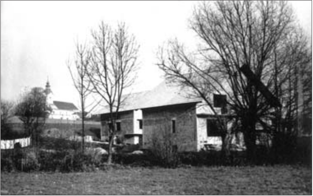
Slika 66: V sedemdesetih letih 20. stoletja so nove stavbe zrasle na poplavni ravnici potoka Reke pod Komendo (Radinja in ostali 1973).
