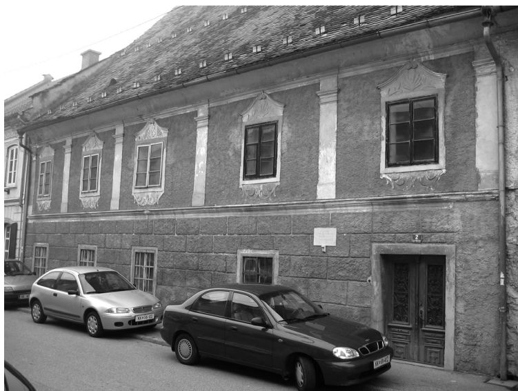
Slika 2: Prava Valvasorjeva hiša v Krškem
