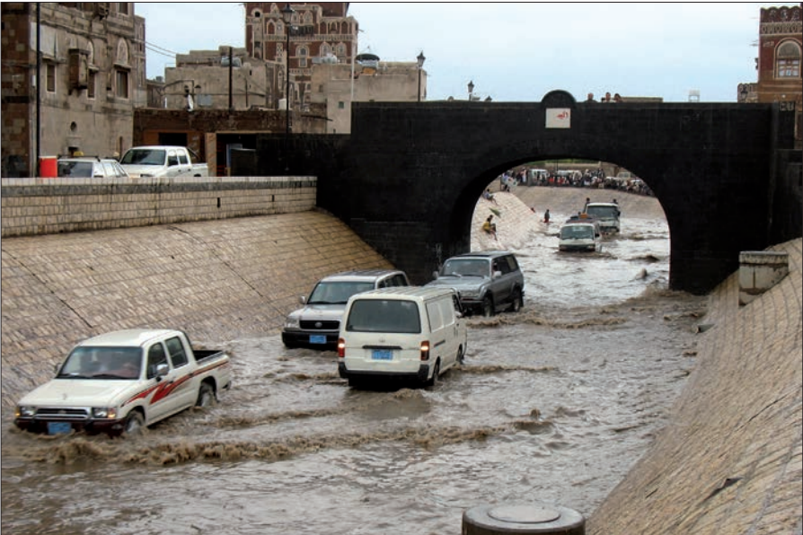
Isti kanal nekajkrat letno opravlja svojo primarno funkcijo, to je odvajanje odvečne vode po dežju. Foto: Vojislav Likar.
