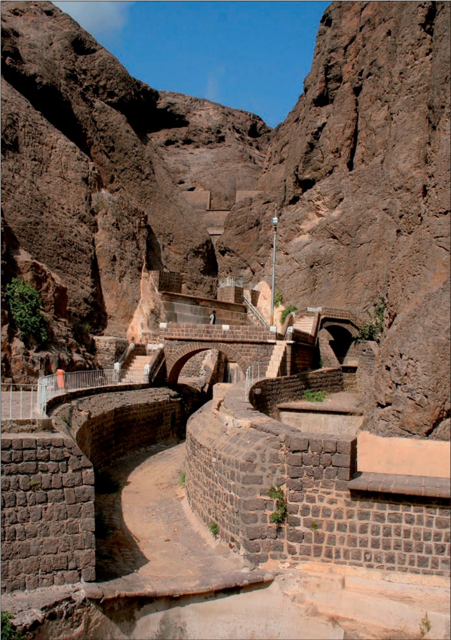
Aden pred hudourniškimi poplavami varuje in hkrati ljudem zagotavlja pitno vodo niz zapornic, kanalov in vodnih zbiralnikov. Foto: Krištof Kranjc.
