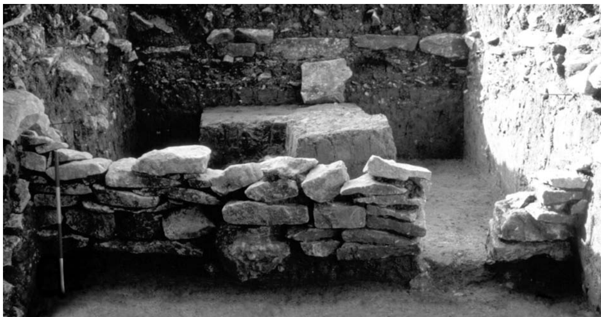
Fig. 62: Veliki Vinji vrh near Bela Cerkev. Retaining wall. Sl. 62: Veliki Vinji vrh nad Belo Cerkvijo. Podporni zid.
